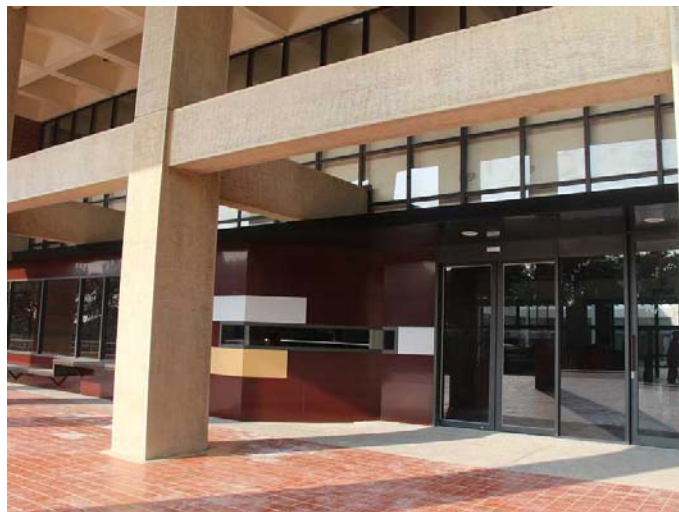
2013年1月28日整建完工的大門
