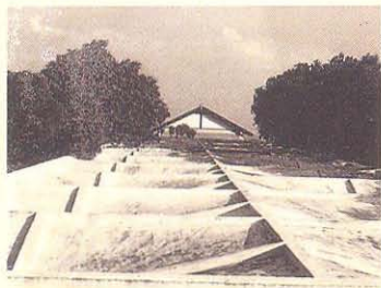
舊建築系館的薄殼屋面。
