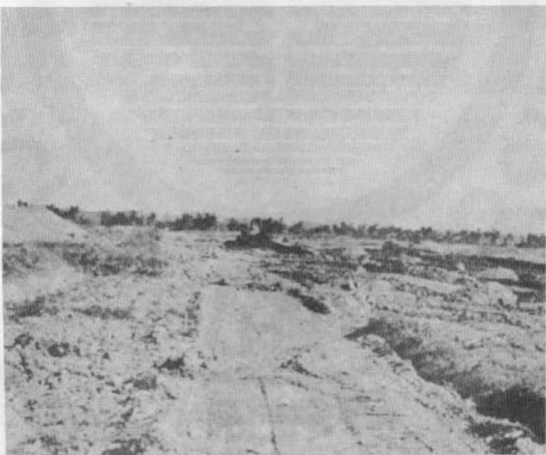
在荒坡上開出第一條道路
