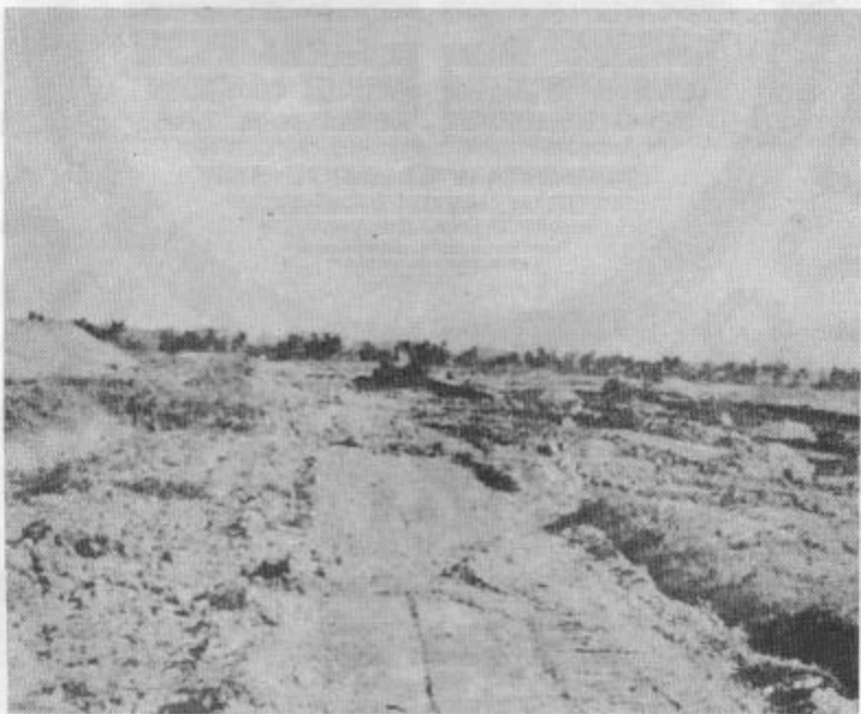
在荒坡上開出第一條道路
