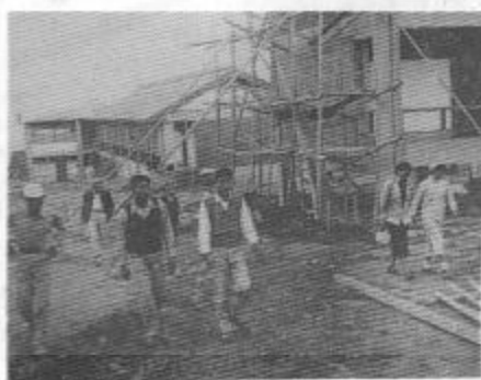
興工中的首期工程—男生宿舍(二)
