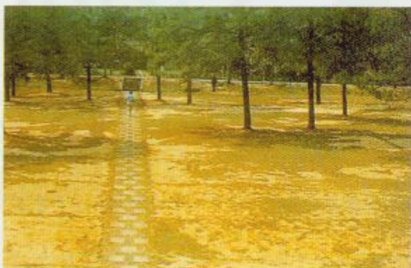
體育館前路面鋪磚，增加地面的硬度，便於行走。
