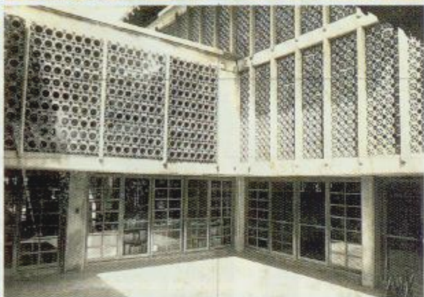
舊圖書館山牆上由磚砌成的漏牆。(張運宗攝)
