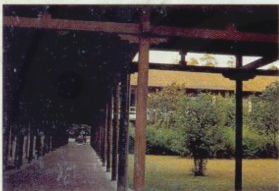
院落的柱廊是連接室內與室外的過渡空間。(吳宗軒攝)
