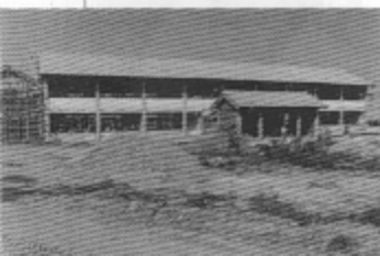
接近完工的「夜間部大樓」
