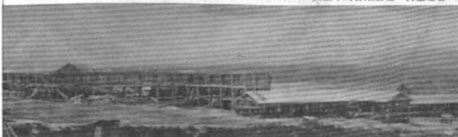
興工中的首期工程—男生宿舍(一)
