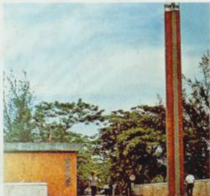
因台中港路拓寬工程而拆除的舊校門。
