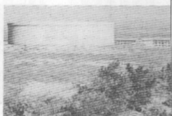
水塔工程完成
