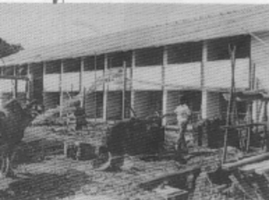
衛理樓的施工情形
