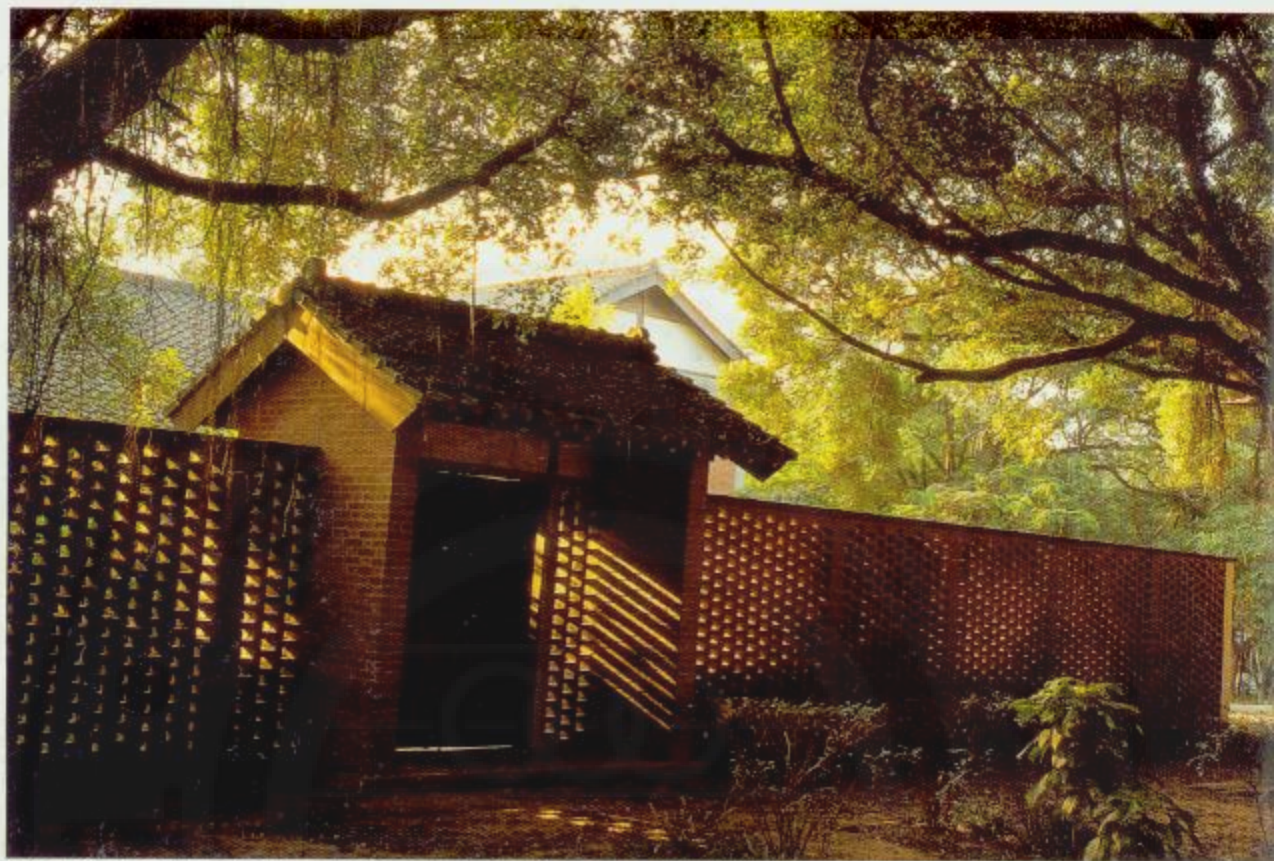
男生宿舍交誼廳山門的磚砌漏牆，在陽光穿透下，漏牆的美觀、通風、遮隔與開放的特性，表露無遺。(吳宗軒攝)
