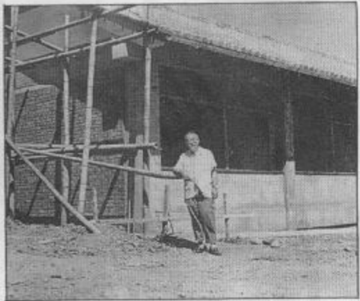
東海在開創中(建築中的行政大樓)
