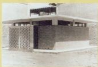
工學院實驗室， 現已改為廁所。
