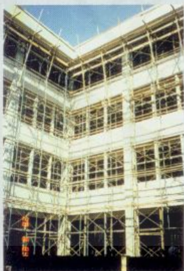
即將完工的新圖書館。
