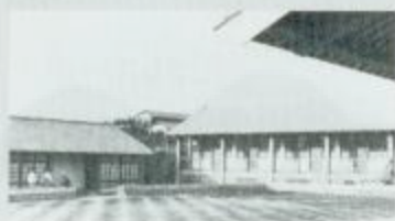
完工的學生活動中心廣場，圖左小屋即「奧柏林室」。
