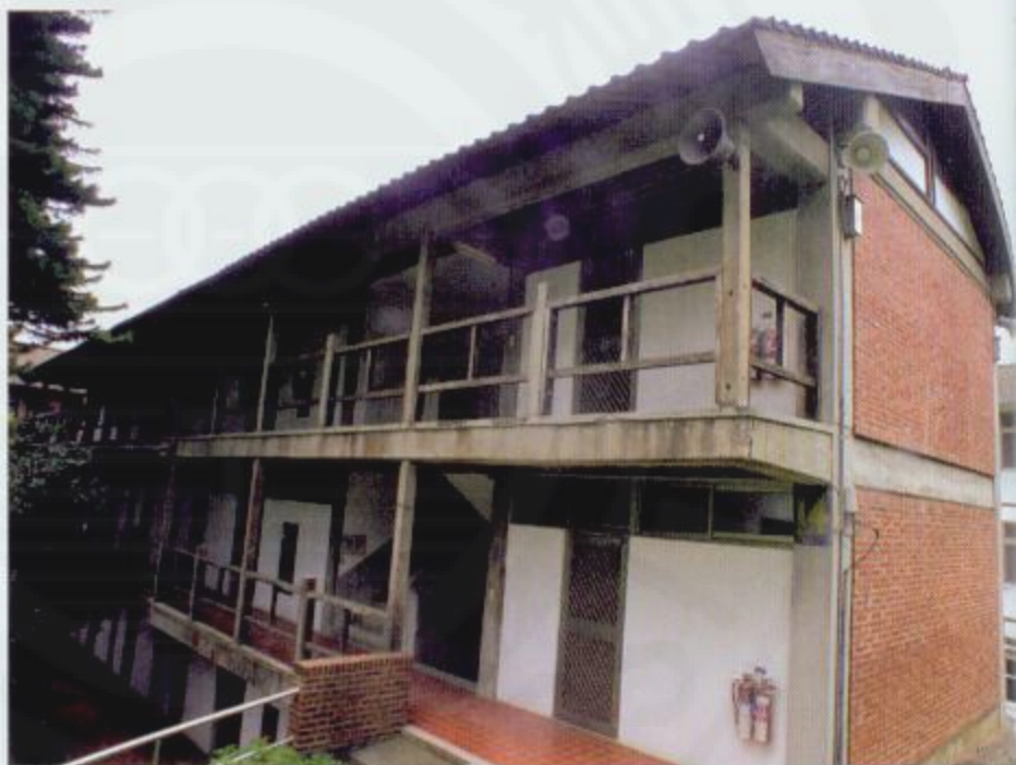
11月完工的3層女生宿舍第14棟。
