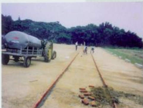
興工中的IBA 穿越東海牧場 抵東大附小的 道路。
