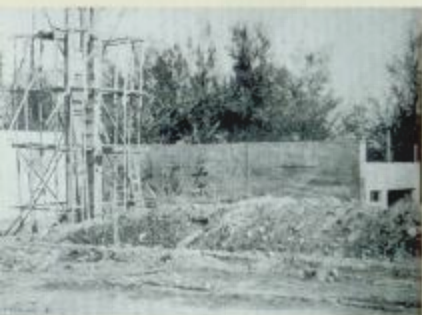
即將完工的新校門。
