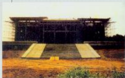
滿佈鷹架的新圖書館。
