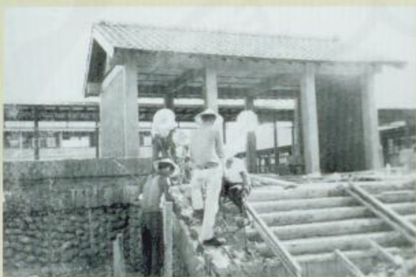
即將完工的文學院，工人正在修築台階。
