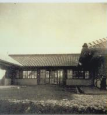
新建完工的 醫務室。
