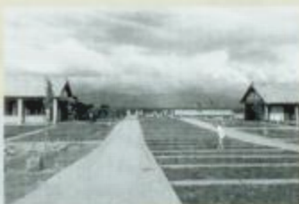
即將完工的文理大道，電線已經地下化，正在進行植草和路口工程。
