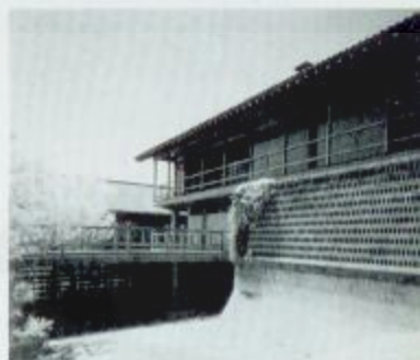
女舍以漏牆展現隱約穿透的美感，並依天然地形梯層設計，藉迂迴曲折的橋與廊串連各棟層。
