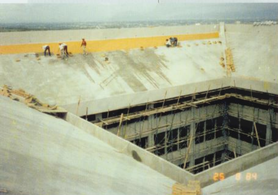
新圖書館的屋頂工程。
