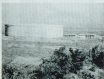
完工後的水塔。
