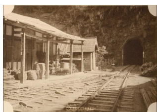
圖 26 梨園寮驛旁的隧道 （資料來源：臺灣大學）
