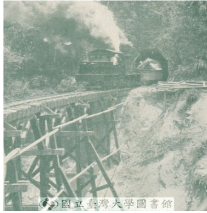
圖 30 五號隧道西口 (資料來源：臺灣大學)
